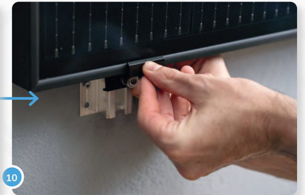
10 Die Klemmen werden von oben bzw. vorne in die Schienen gedrückt. Beim Hinunterdrücken dreht sich die Feder um 90° und schnappt ein.
