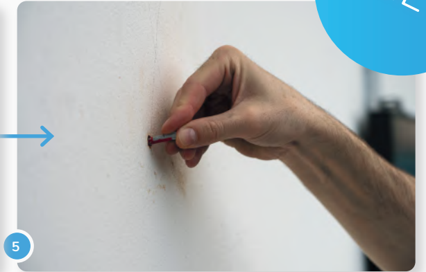
5 ...und stecke dann die Wanddübel hinein.
