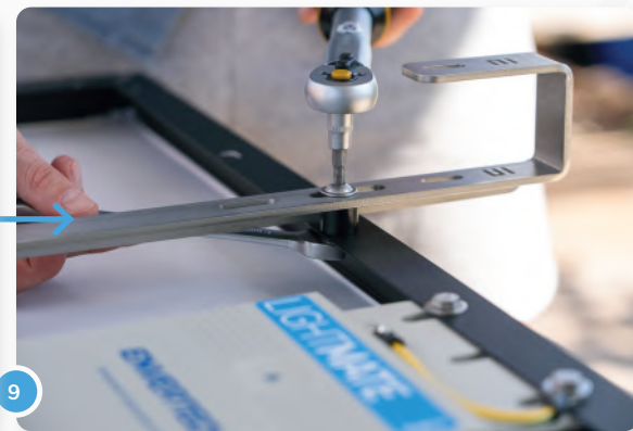
9 Bitte fixiere die Haken dann mit den Schrauben und Sicherheitsmuttern am Panel.
