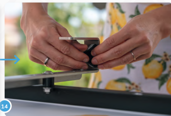
14 Wenn du einen eckigen Handlauf hast, kannst du jetzt die Gummistreifen als Kratzschutz einkleben.
