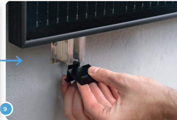
9 Bringe nun das Panel in die gewünschte Position und lass dir beim Anbringen der Klemmen von jemandem helfen.
